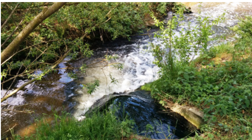
Abb. 3 Auflauf einer Kläranlage in den Fluss Rodau
